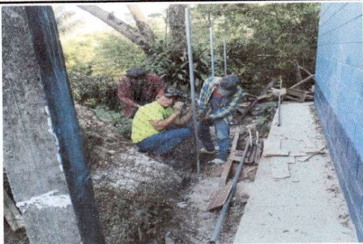
Foto 7: Reparación de tubo HG.
