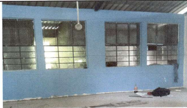
Foto 6: Pintura en muros interiores.
