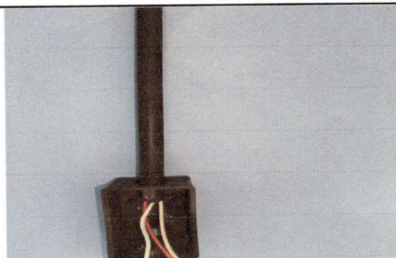
Foto 10: Reparación de cableado eléctrico, sustitución de ducto eléctrico mas accesorios.
