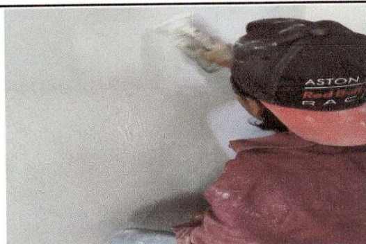
Foto 11: Reparación de repello y cernido de paredes.
