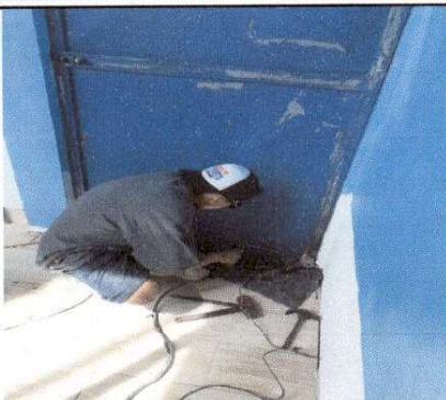
Foto1: Mantenimiento a estructura (lijado, cambio de tubo, cepillado, sujeción, aplicación de pintura).
