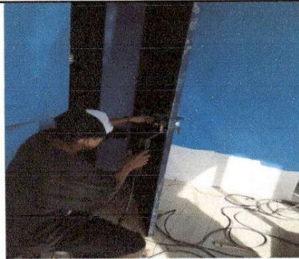
Foto 2: Sustitución de chapa.
