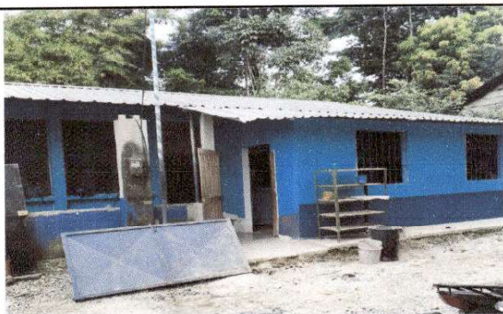
Foto 5: Pintura en muros exteriores.
